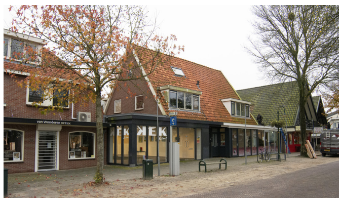
Onderbouw gesloopt voor brede winkelpuien
