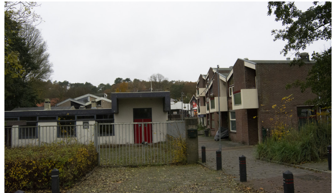
Het vervallen postkantoor zal plaatsmaken voor een park
