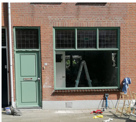
Gevel aanhalen met passende gevelstenen en raamkozijnen
