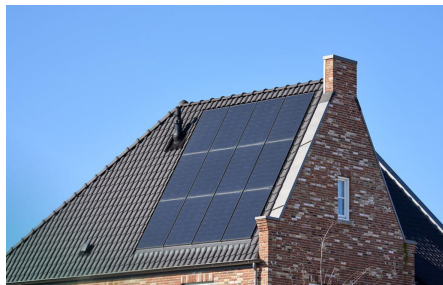
Zonnepanelen geïntegreerd in dakvlak
