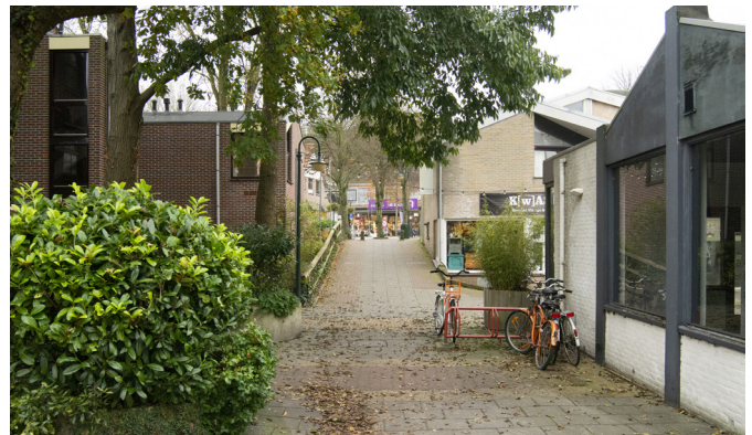
Donkere gevels aan de noordzijde
