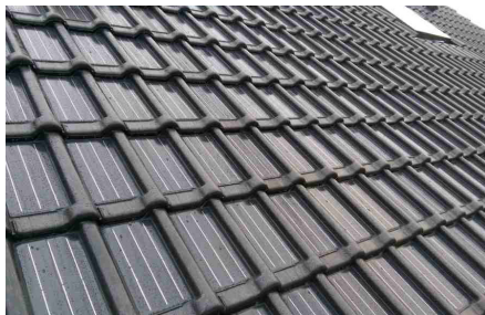
Zonnepanelen verwerkt in dakpan
