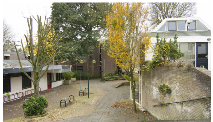
Donkere gevels aan de noordzijde
