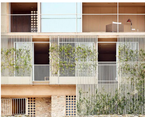
Architectonische zonneschermen verwerken in de gevel
