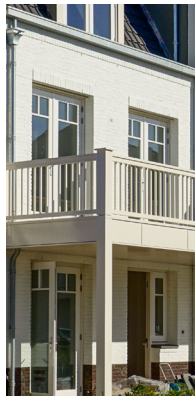
Luifel vormgeven als veranda
