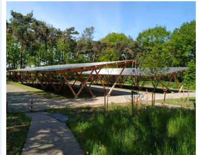
Afbeelding 12 - Zonnepanelen boven in parkeervoorziening
