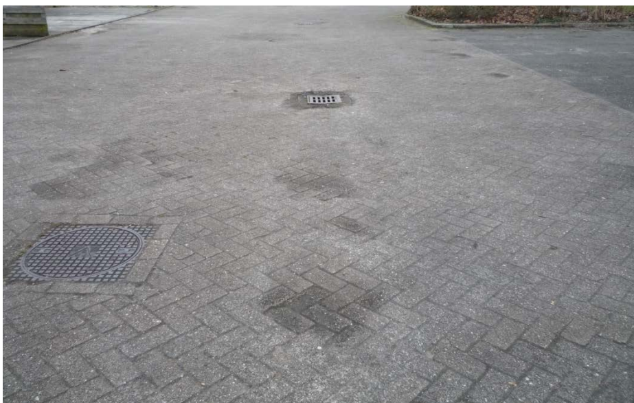
Elementenverharding: Kwaliteitsklasse matig
