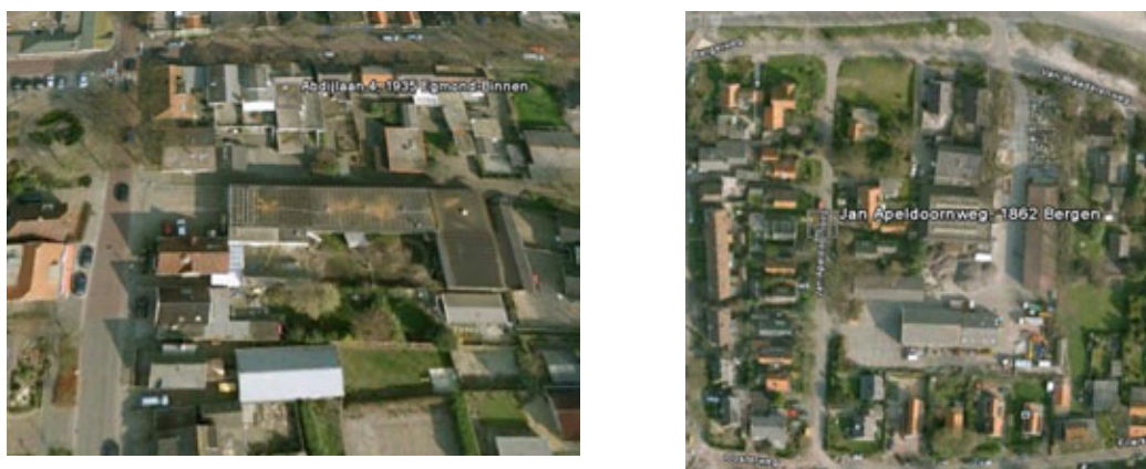
Figuur 3.2. Huidige locatie aannemersbedrijf (rechts) en staalconstructiebedrijf (links)
