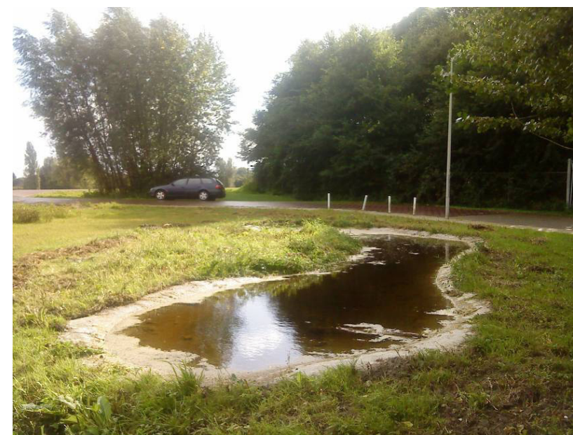
Figuur 16: Poel aangelegd op aangrenzend perceel. De poel heeft een betonnen vloer, met daarover zand. Deze is eenvoudig periodiek te schonen, waarmee de poel duurzaam te gebruiken is voor de rugstreeppad. Let ook op de ondiepe oeverzone (bron: Gerard Smit).
