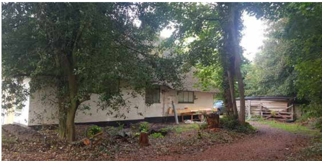
Strook tuin aan de zijde van de woning waar de uitbouw gerealiseerd zal worden.
