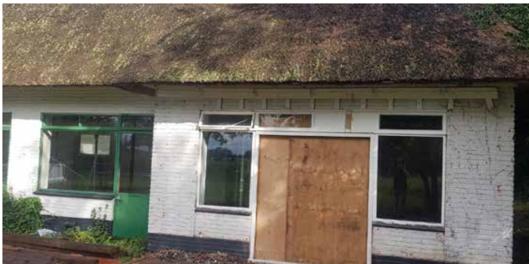
De villa ter plaatse van de uitbouw.
