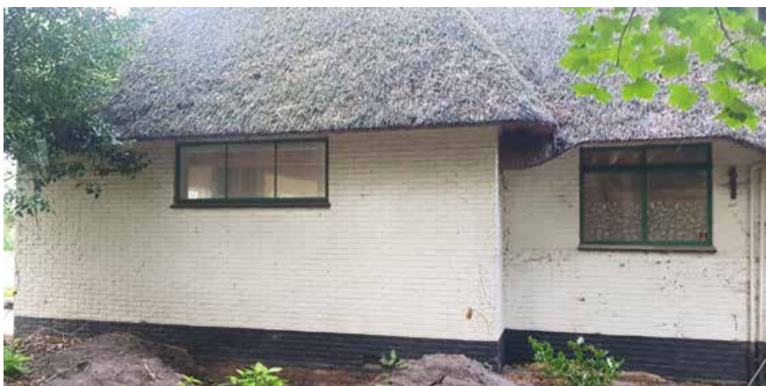
De villa ter plaatse van de uitbouw.
