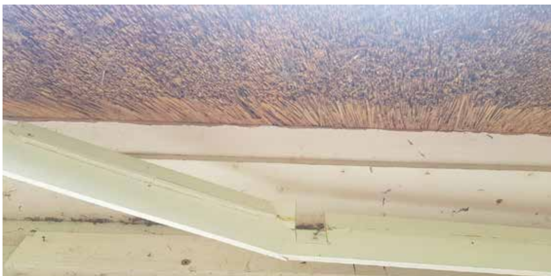
Het dak van de villa ter plaatse van de uitbouw.
