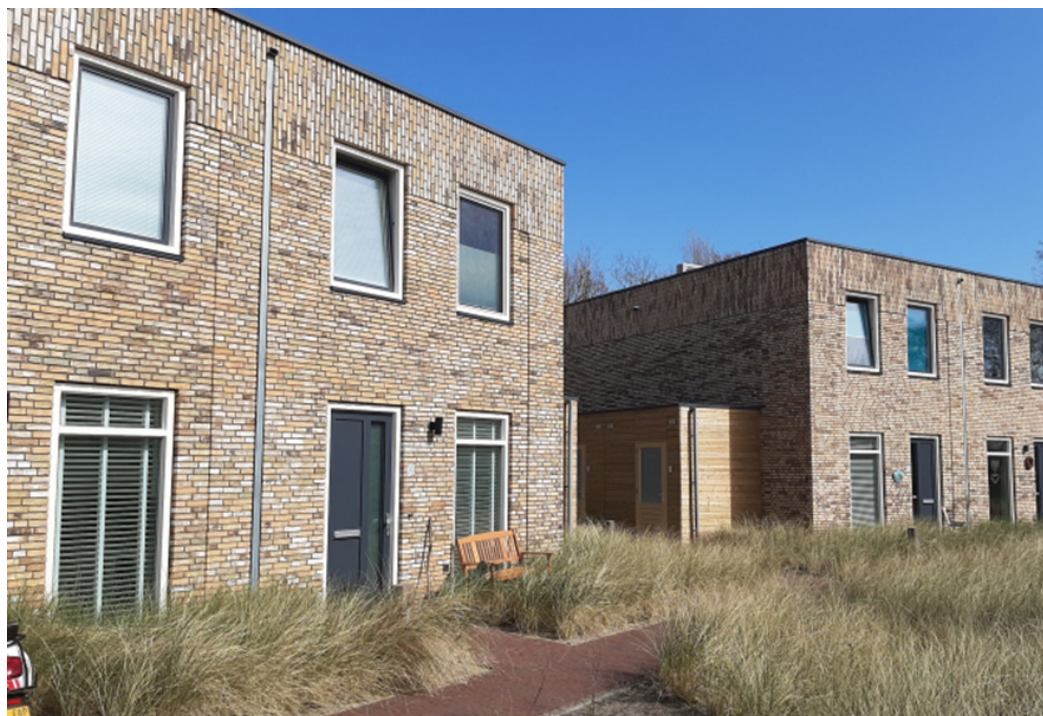
hemelwaterafvoer in de gevel
