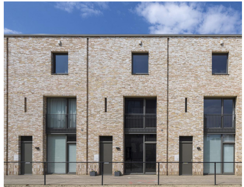
verticale geleding op de bouwmuur
