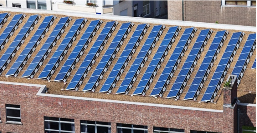
inpassing zonnepanelen binnen hoge dakrand (bron: www.docplayer.nl )
