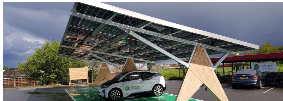
constructie voor zonnepanelen boven parkeerplaats
