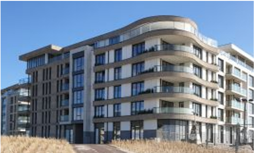
afgeronde hoeken met balkons binnen de gevellijn
