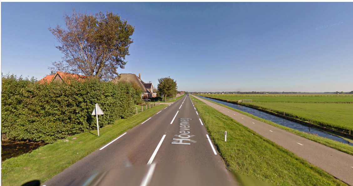
Figuur 4.1. Verkeerssituatie ter plaatse
