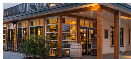
Veranda op de begane grond
