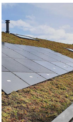
De flauwe daken zijn geschikt voor Sedumdaken gecombineerd met zonnepanelen
