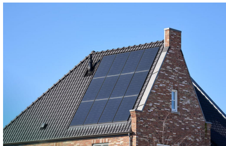
Zonnepanelen geïntegreerd in dakvlak
