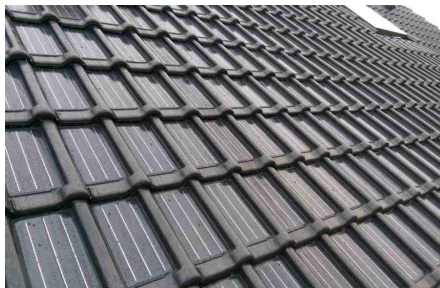
Zonnepanelen verwerkt in dakpan
